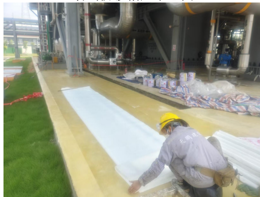
施工过程中防渗涂布施工
