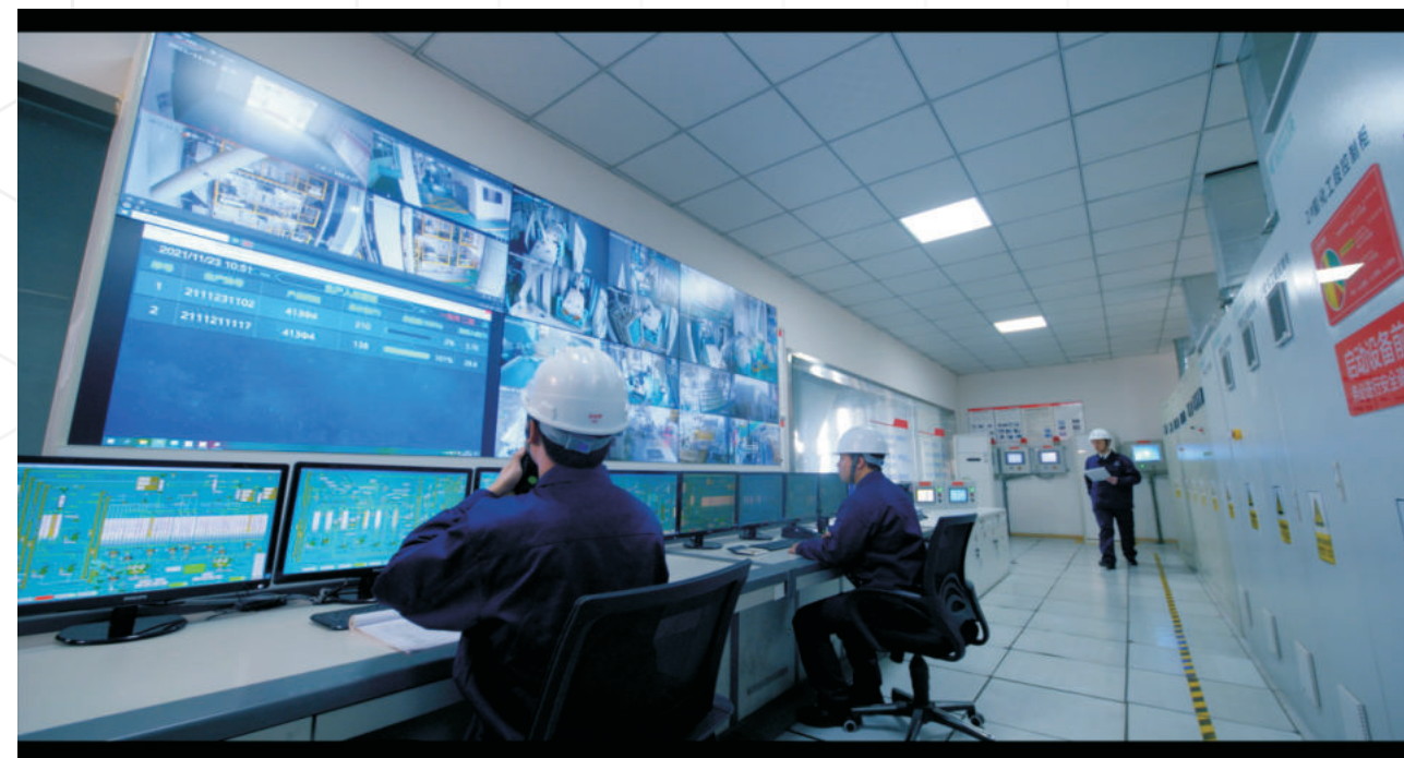
■ 通威现代化的饲料生产线 ■ Tongwei modern feed production line
