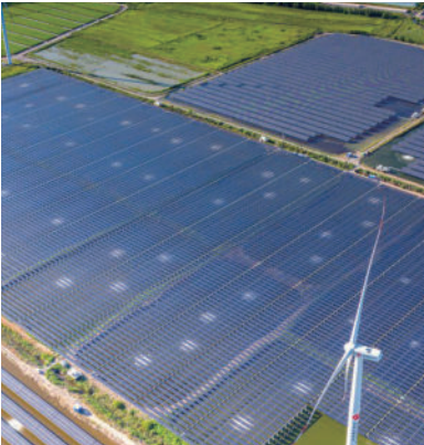
天津大港电站
