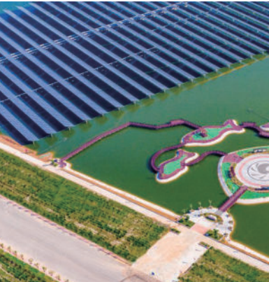
山东东营黄河口电站
