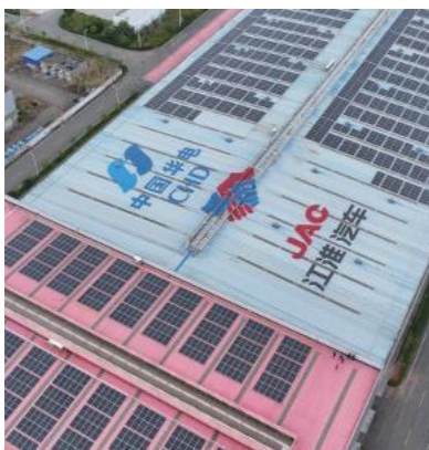
华电遂宁安居江淮汽车一期光伏项目 项目容量 | 194.5kW
