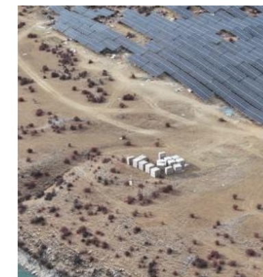
华电墨竹工卡扎雪牧光互补光伏发电项目
