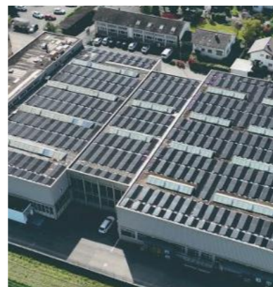
瑞士工商业屋顶项目 项目容量 | 1MW
