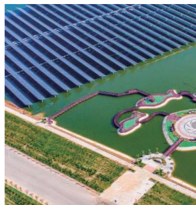
山东东营黄河口电站 项目容量 | 195.5MW
