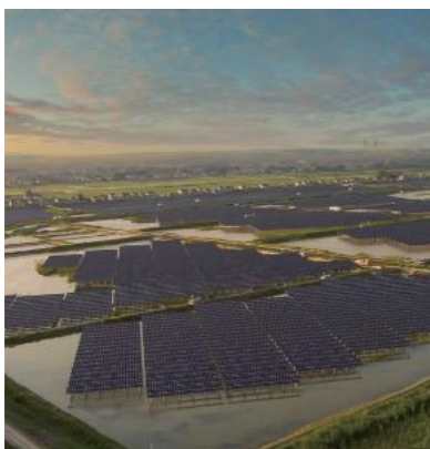
江苏南京龙袍电站 项目容量 | 53MW
