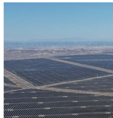
青海共和90万千瓦光伏项目
