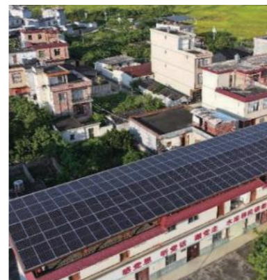
广西创维小阳楼光伏项目
